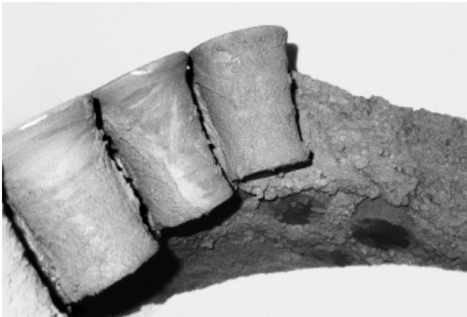
2: Nach dem Setzen der Kacheln müssen die Zwischenräume mit Lehm gefüllt werden.
